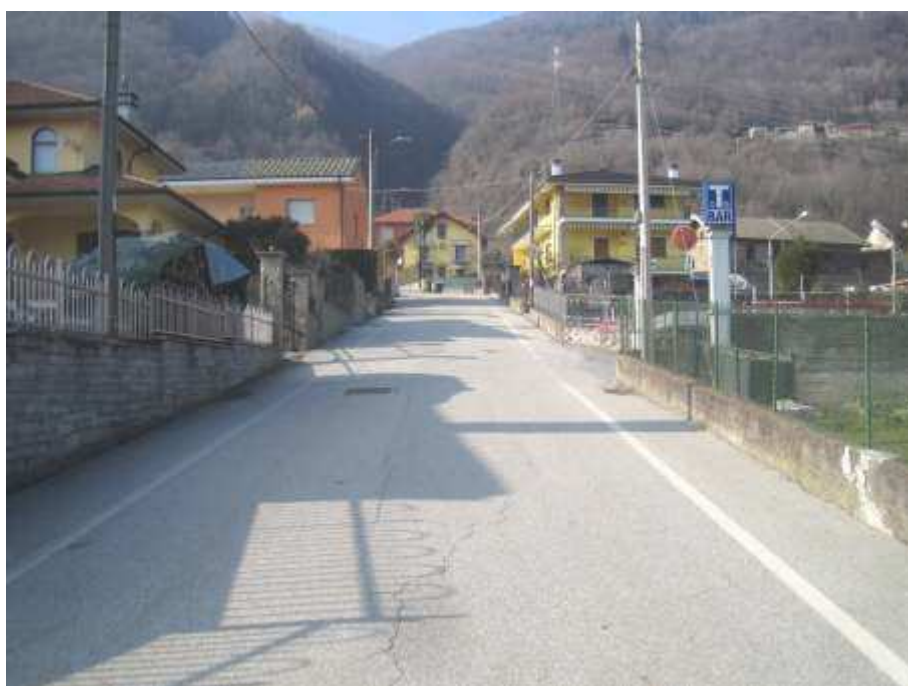
Strada Comunale che risale l'abitato di Gabi Valle, lungo la linea di massima pendenza, con muri in elevazione laterali, discontinui.
