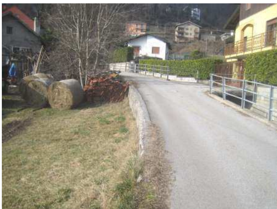
Rio Zoncalina, canale in conoide, porzione medio-distale: in caso di esondazione lungo la strada, i deflussi di piena si riverserebbero nei terreni prativi in destra idrografica, posti ad una quota evidentemente inferiore.
