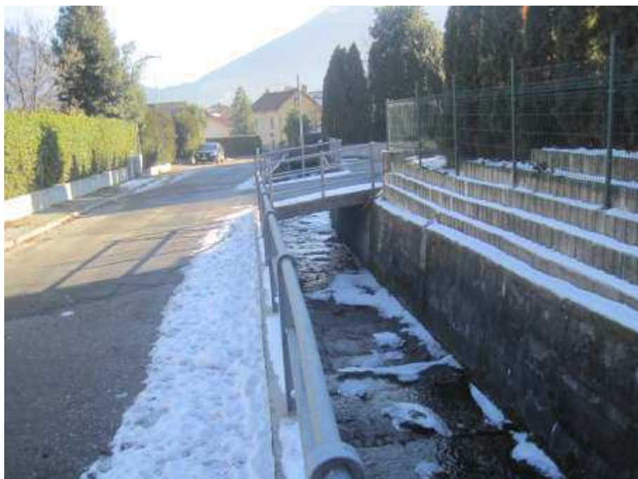
Rio Riana, canale in conoide: i terreni in destra idrografica sono posti a quote più elevate rispetto al piano stradale ed ai terreni in sinistra; in fregio alla strada, i muri in cls in elevazione contribuiscono a contenere gli eventuali deflussi di esondazione lungo il piano viario
