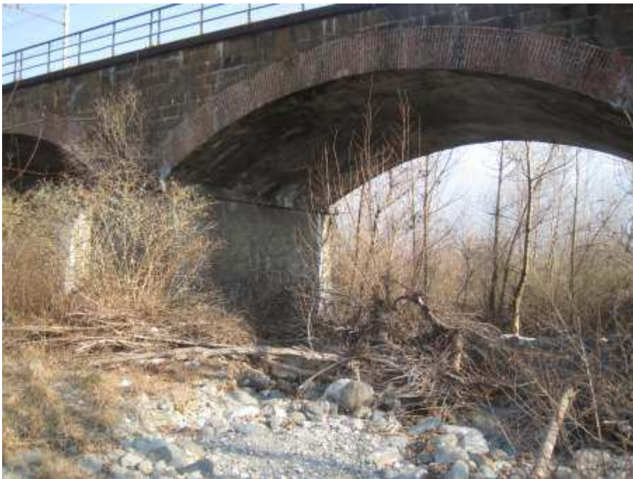
Ponte ferroviario, con accumuli di detrito vegetale, depositati nel corso dell'evento dell'ottobre 2020, e marche di piena di altezza relativamente modesta
