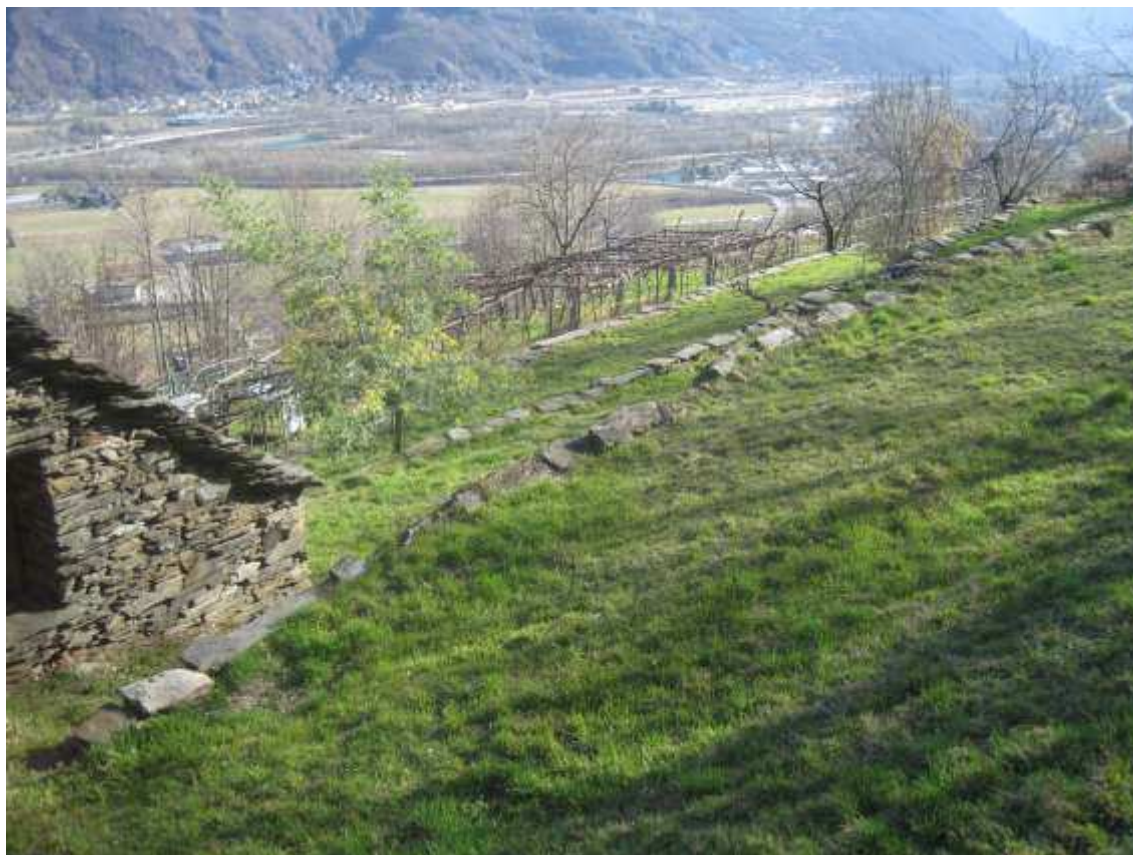
Area terrazzata e stabile, lungo la strada per Anzano, riclassificata dalla Classe IIIA alla Classe II
