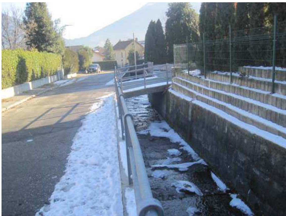
Conoide del Rio Riana, lungo via G. Ceschi I terreni in sponda destra, posti ad una quota più elevata rispetto alle aree in sinistra idrografica, sono stati riclassificati dalla Classe IIIb3 alla Classe IIIb2
