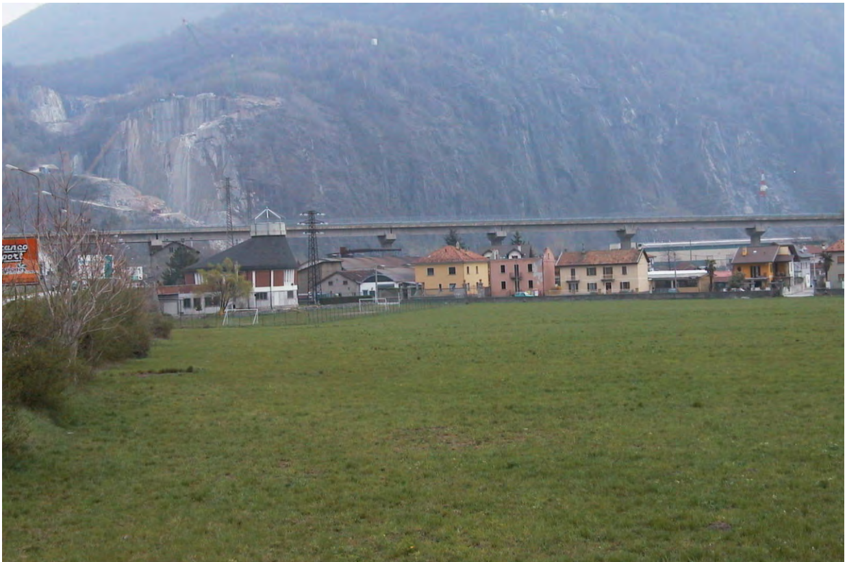
Intervento 27: Veduta da Ovest dell'area che sarà interessata dalla realizzazione del centro A.N.F.F.A.S.; Sullo sfondo si vede la chiesa di Badulerio.
