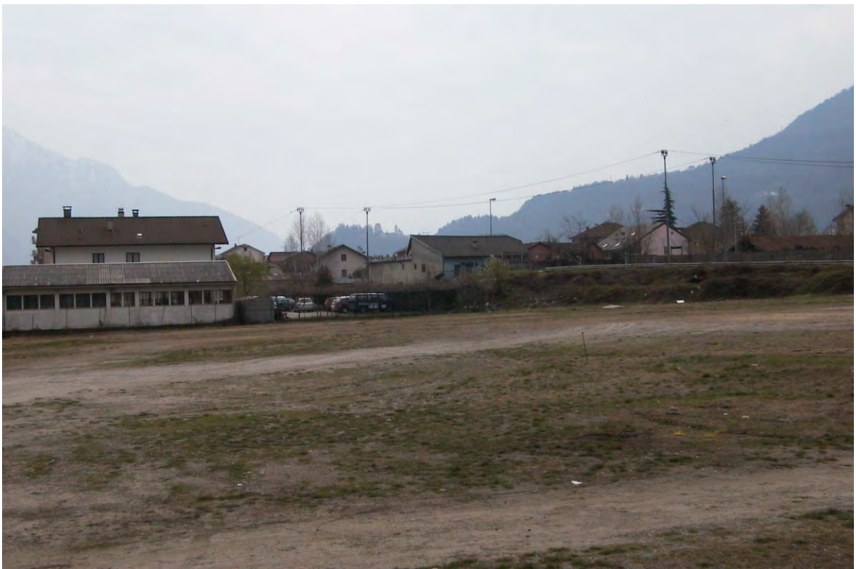
Intervento 13: veduta da Nord dell'area situata immediatamente a Sud-Est del Campo Sportivo, ove si imposterà la tratta finale del nuovo tracciato stradale; è visibile, sullo sfondo, il rilevato ferroviario.
