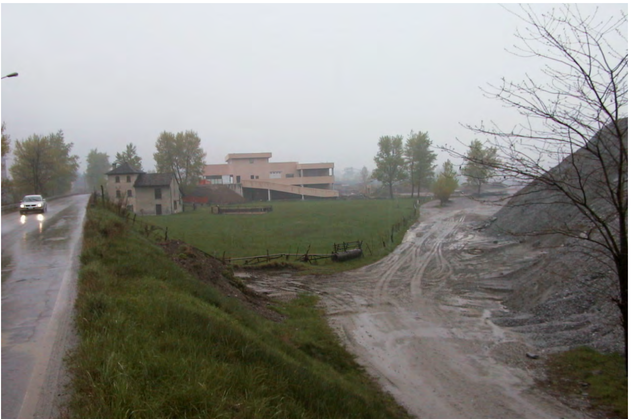
Intervento 11: veduta da Sud dell'area commerciale di completamento, con parcheggio annesso, attualmente tenuta a prato a sfalcio; si nota come l'area risulti attualmente delimitata dai settori circostanti rilevati.
