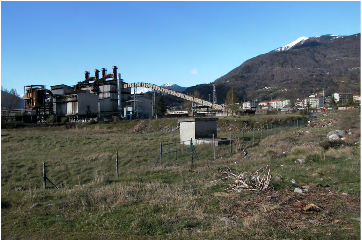
Intervento 10: veduta da Nord-Est dell'ampia area, con settori riquotati, della ditta INDEL s.p.a.; risulta ben visibile il capannone principale della ditta, attualmente dismesso.
