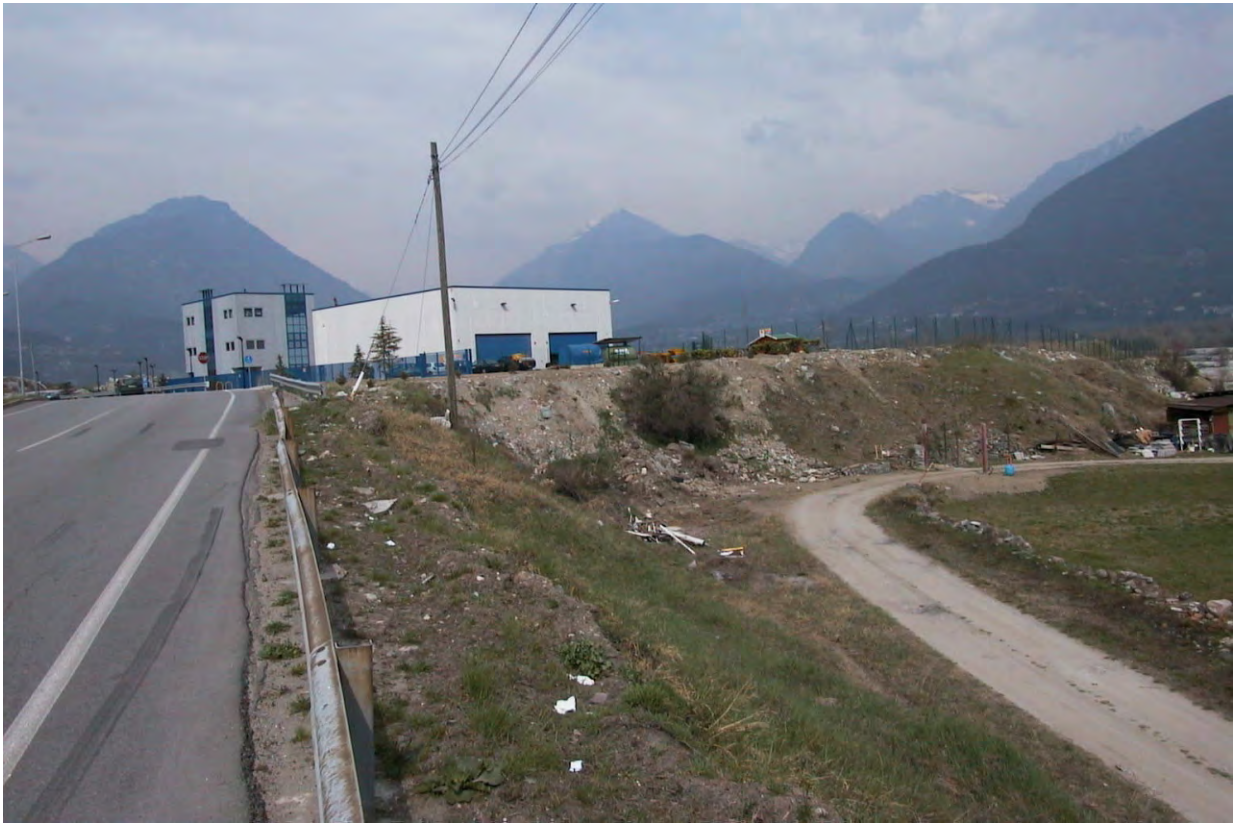
Intervento 26: Veduta del settore centrale, in corrispondenza del rilevato dell'area Eliossola.
