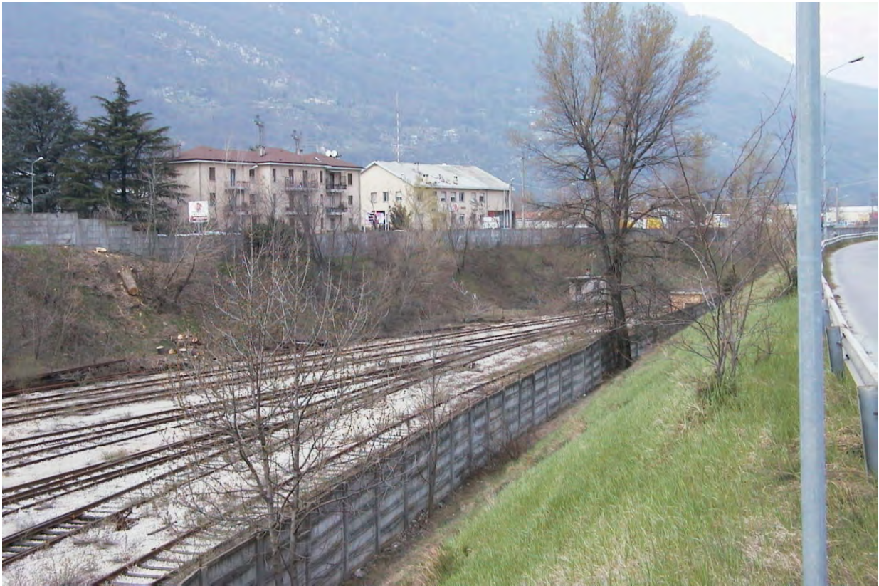
Intervento 25: Veduta del settore centrale della grossa area ferroviaria depressa, compresa tra i due rilevati stradali.
