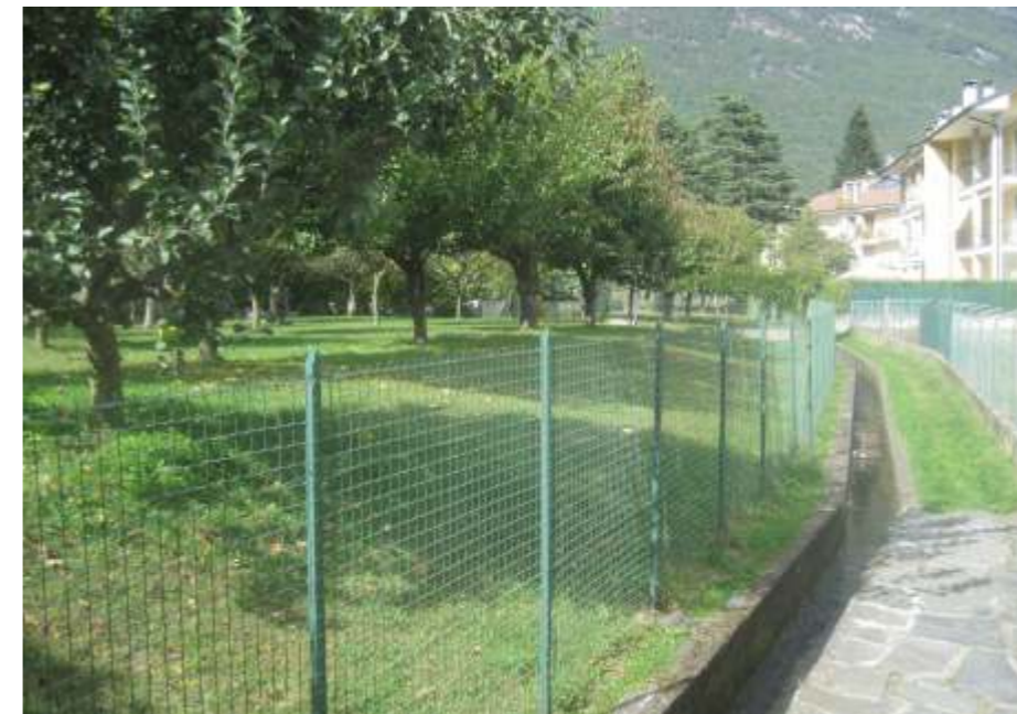
Veduta dal vertice Sud-Est, con particolare del canale di derivazione
