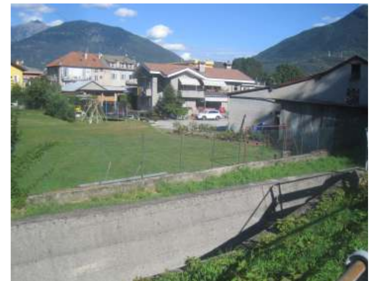
Settore orientale; a destra vi è il fabbricato da demolire
