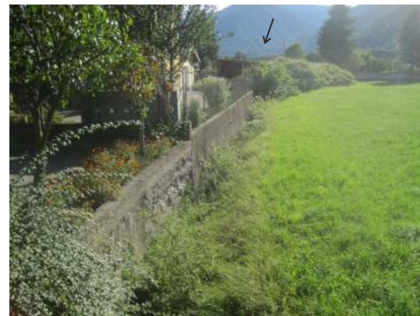
Veduta da NE dell'ex roggia irrigua (la posizione dell'area 66B è indicata dalla freccia sullo sfondo)
